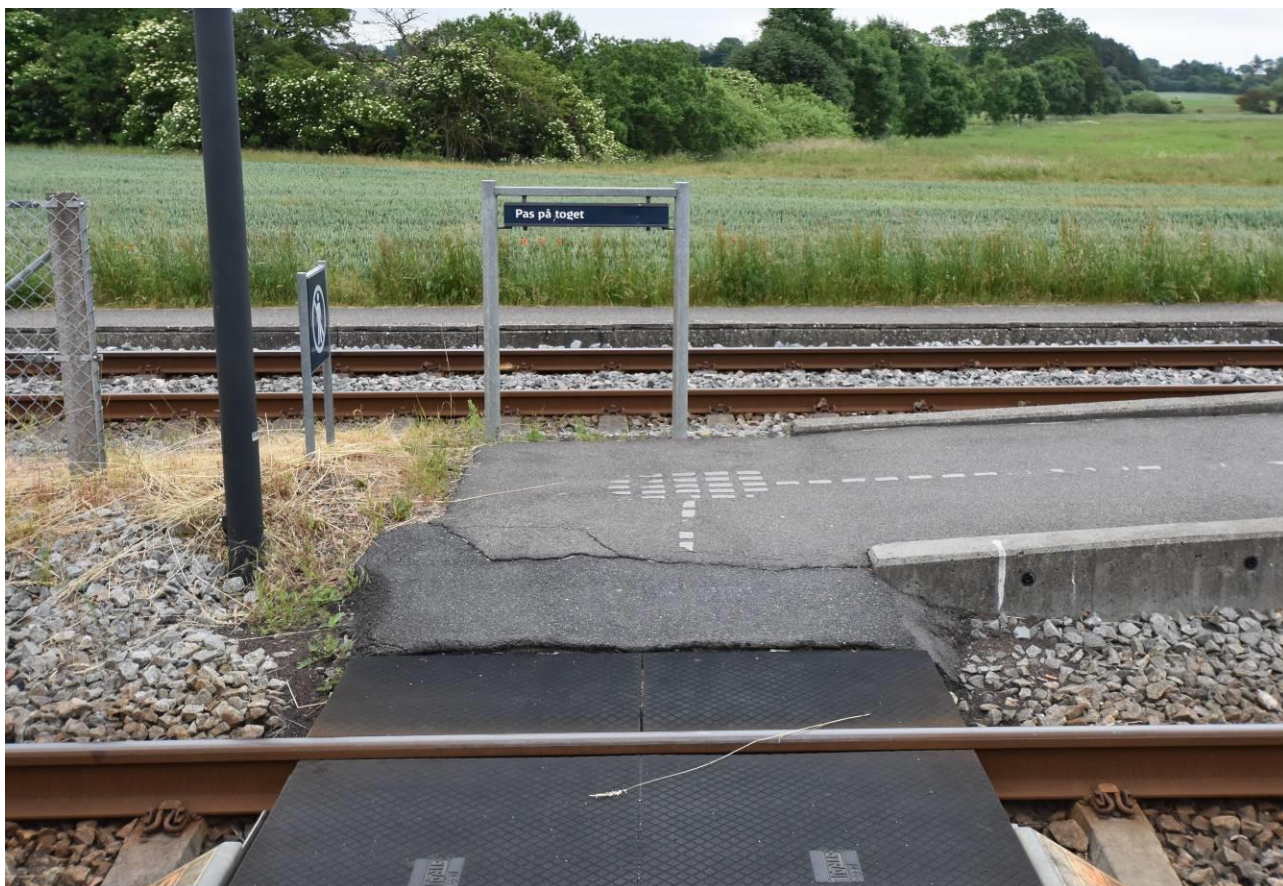
Perronovergangen på Stenstrup station
